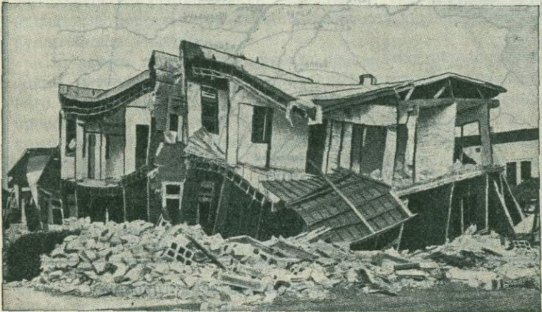
Рис. 23. Полное разрушеніе дома вслѣдствіе недостаточно прочной связи между стѣнами и крышею. Землетрясеніе въ Санъ-Франциско (1906 г.).
