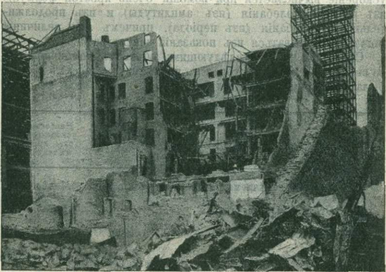
Рис. 22. Полное разрушеніе дома при землетрясеніи въ Санъ-Франциско (1906 г.).
