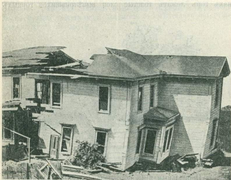
Рис. 7. Деревянный домъ, разорванный пополамъ при землетрясеніи въ Санъ-Франциско (1906 г.).
