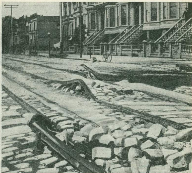
Рис. 14. Волнообразно изогнутая мостовая и рельсы при землетрясеніи въ Санъ-Франциско (1906 г.).
