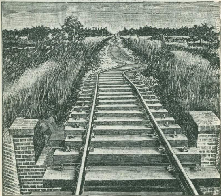
Рис. 13. Горизонтальный сдвигъ полотна желѣзной дороги у Ранганара во время остъ-индскаго землетрясенія 1897 г.
