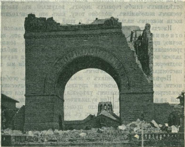
Рис. 18. Обвалъ угла арки Леландъ-Станфордскаго университета при землетрясеніи въ Санъ-Франциско (1906 г.).
