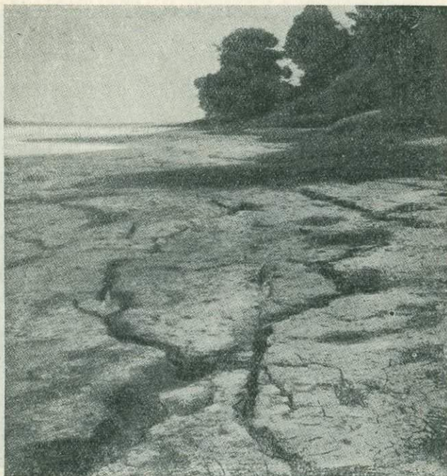
Рис. 11. Вторичныя трещины на поверхности земли при землетрясеніи въ Санъ-Франциско (1906 г.).
