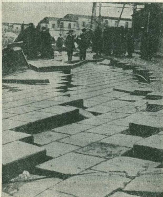
Рис. 15. Опусканіе полосы мостовой въ Мессинѣ (1909 г.).
