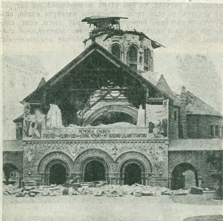
Рис. 5. Обвалъ передней стѣны въ церкви Леландъ-Стан- фордскаго Университета при землетрясеніи въ Санъ-Фран- циско (1906 г.).
