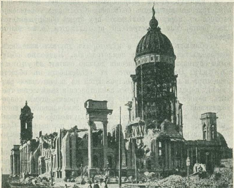
Рис. 17. Городская ратуша въ Санъ-Франциско. Разрушеніе всей каменной облицовки при сохраненіи желѣзной основы.
