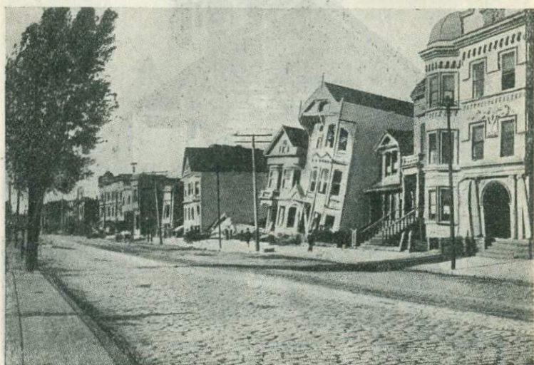
Рис. 6. Паденіе деревянныхъ домовъ, построенныхъ на наносной почвѣ, при землетрясеніи въ Санъ-Франциско (1906 г.).
