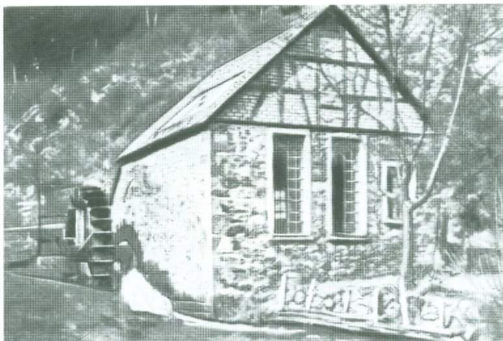
Старая точильня с водяным приводом для шлифовки агатов в Идар-Оберштейне.
