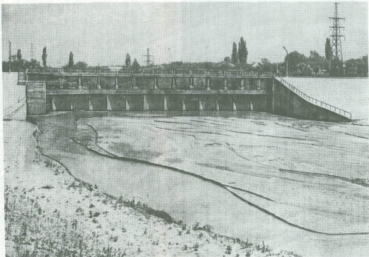
Рис. 13.8. Наносоотстойник на реке Большая Алматинка
