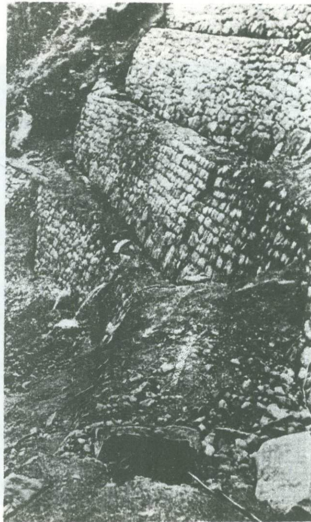
Рис. 19.16б. Ступенчатый габион для защиты искусственного склона по автотрассе в восточных Гималаях
