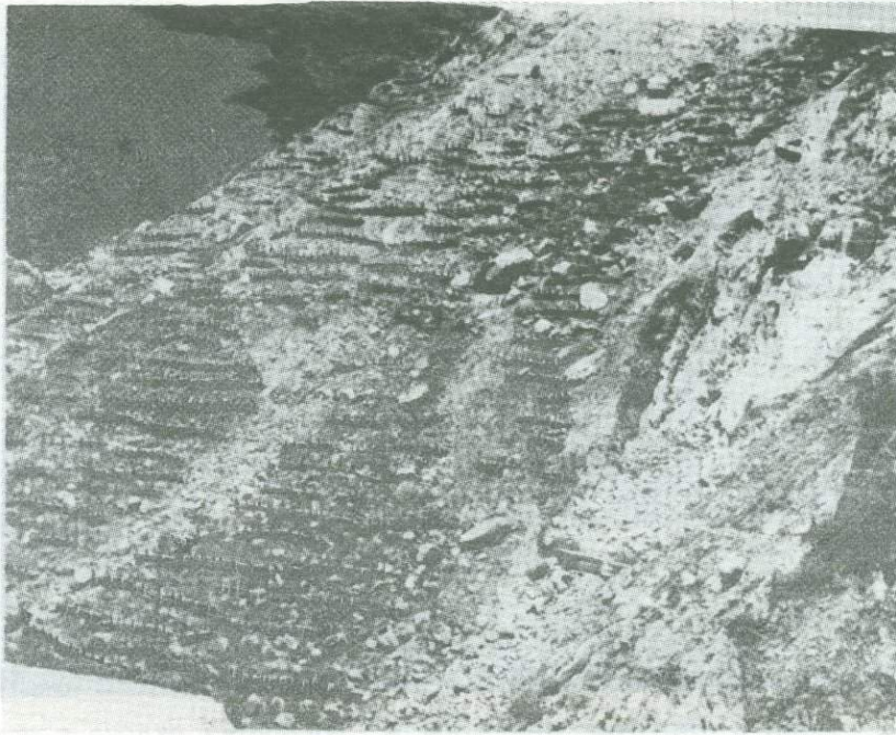
Рис. 19.13. Метод укладки клетки и террасирование в районе Падамчен
