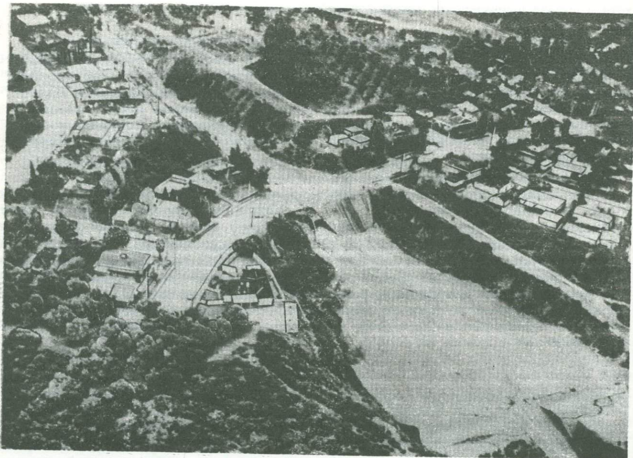
Рис. 18.6. Селеприемник, который был заполнен рыхлым материалом, принесенным грязевым потоком, и переполнен в результате сильных дождей 9–10 февраля 1978 г., горы Сан-Габриэль (фото Джона Шадля, представлено Отделом строительства и техники безопасности Лос-Анджелеса).
