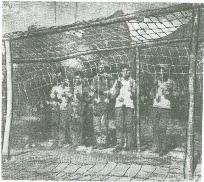
Рис. 19.16а. Ручная вязка проволочных сетей для габионов
