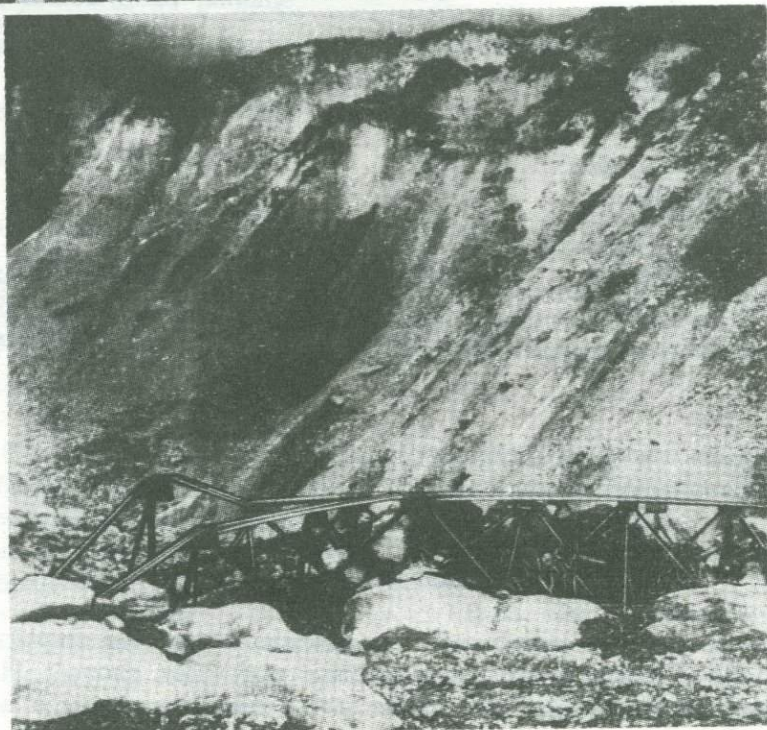
Рис. 19.3б. Река Алакнанда - мост Бирахи, разрушенный во время паводка
