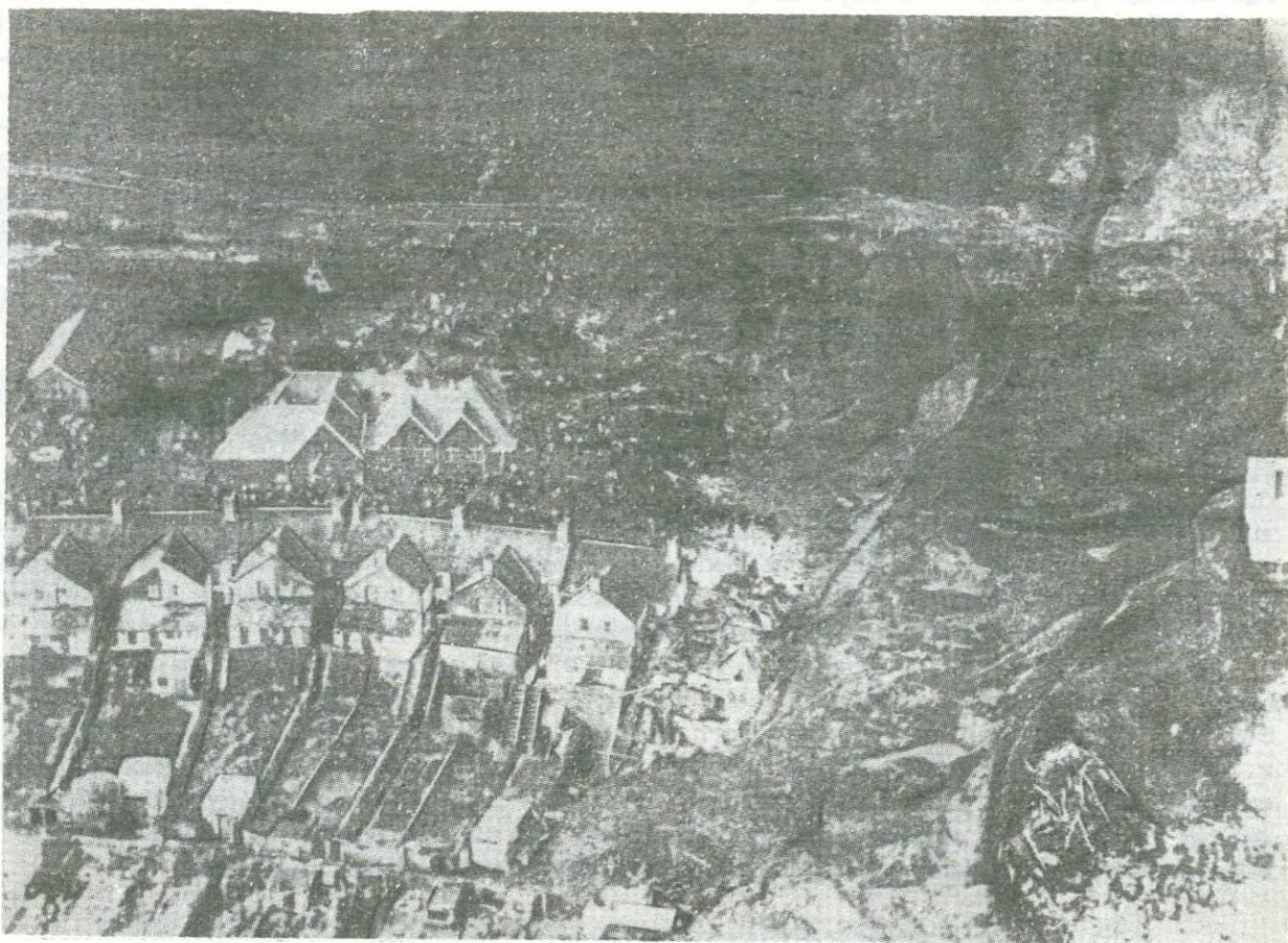
Рис. 23.1. Большой ущерб был нанесен в октябре 1966 г. городу Аберфан в Уэльсе (Великобритания) в результате оползня, вызванного обрушением вершины террикона. Жертвой оползня стали 144 жителя города Аберфан, включая учеников (116 человек) и 5 учителей начальной школы (фотография слева в центре)
