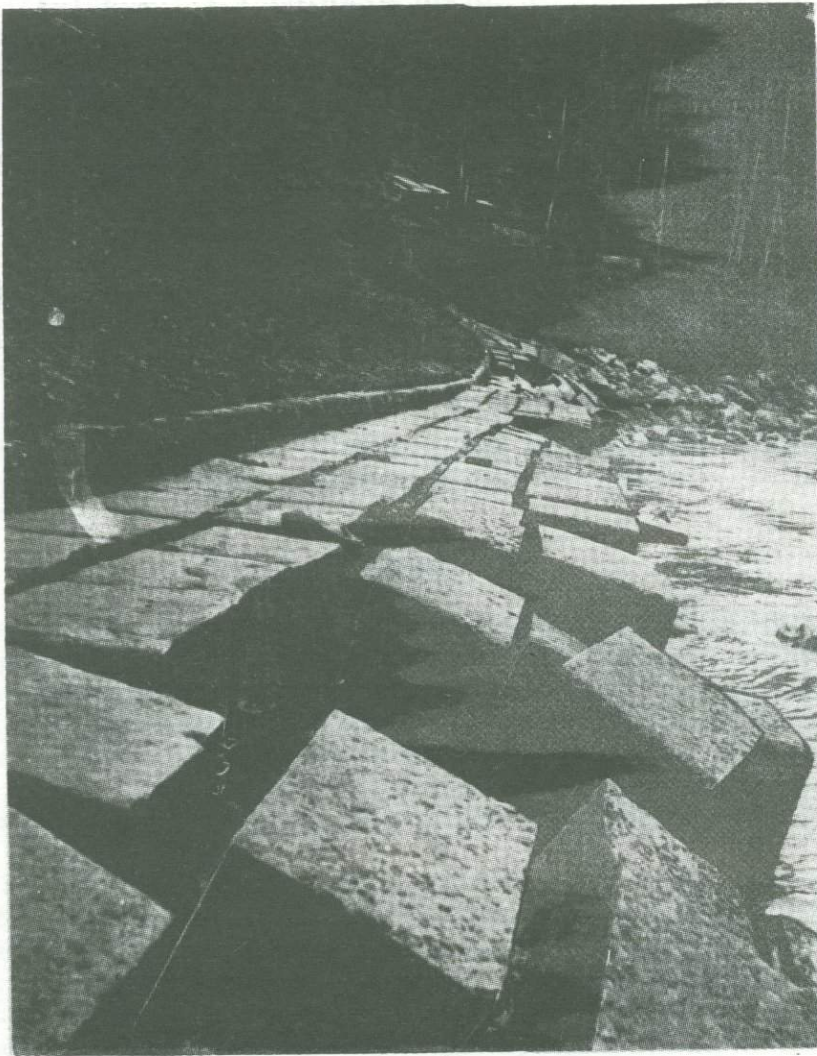
Рис. 19.18. Бетонные блоки в подошве склона
