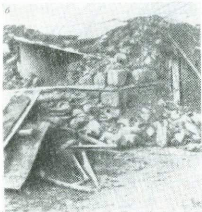
Рис. 76. Разрушение слабых строений (а, б) и кирпича-сырца (в, г)
