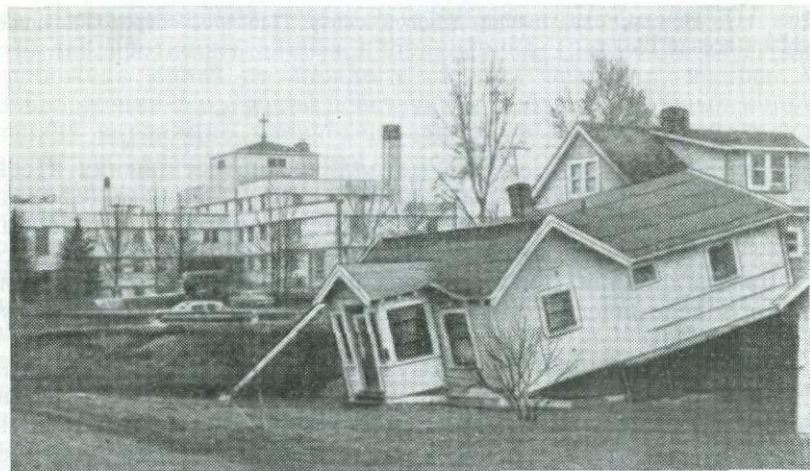
Рис. 116. Деревянные каркасные дома хорошо выдерживают землетрясения если они построены на надежном естественном основании. В результате оседания поверхности в Анкоридже во время Аляскинского землетрясения 1964 г. здание сильно наклонилось, не получив однако, серьезных конструктивных повреждений
