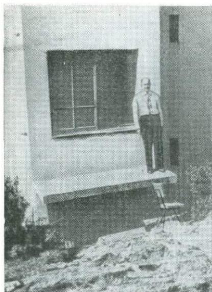
Рис. 122. Здание в г. Ниигате глубоко погрузившееся в рыхлое песчаное основание; первый этаж оказался почти полностью под землей, а козырек над входной дверью стал пунктом наблюдения
