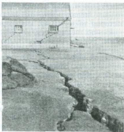
Рис. 131. Эта трещина в грунте и повреждение здания были вызваны смещением грунта по относительно пологому склону при Ляонинском землетрясении
