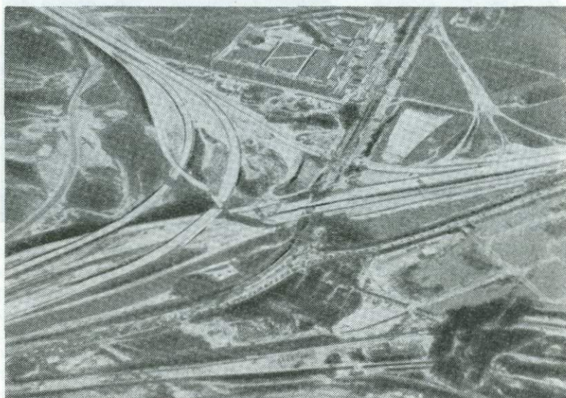
Рис. 129. Несколько мостовых пролетов обрушилось, выведя из строя всю эту сложную транспортную развязку у Сан-Фернандо. Землетрясение, вызвавшее аварию, умеренное с M 6,8
