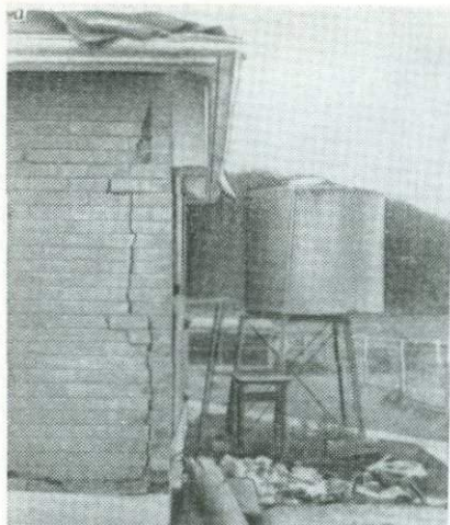
Рис. 105. Цистерна для воды, установленная на устойчивой к сотрясениям металлической платформе, не была на ней закреплена (а); царпины на дне цистерны фиксируют ее перемещения при землетрясении (б)
