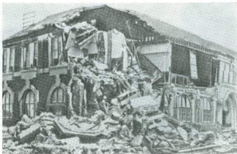
Рис. 104. Разрушенное здание почтамта в Хейстингсе
