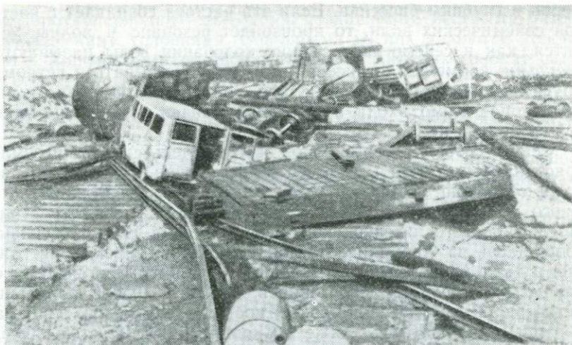
Рис. 87. Разрушения от цунами. Большое Аляскинское землетрясение 1964 г. породило волну высотой 12 м, разрушившую строения, доки и железнодорожные станции вдоль берега зал. Принс-Вильям
