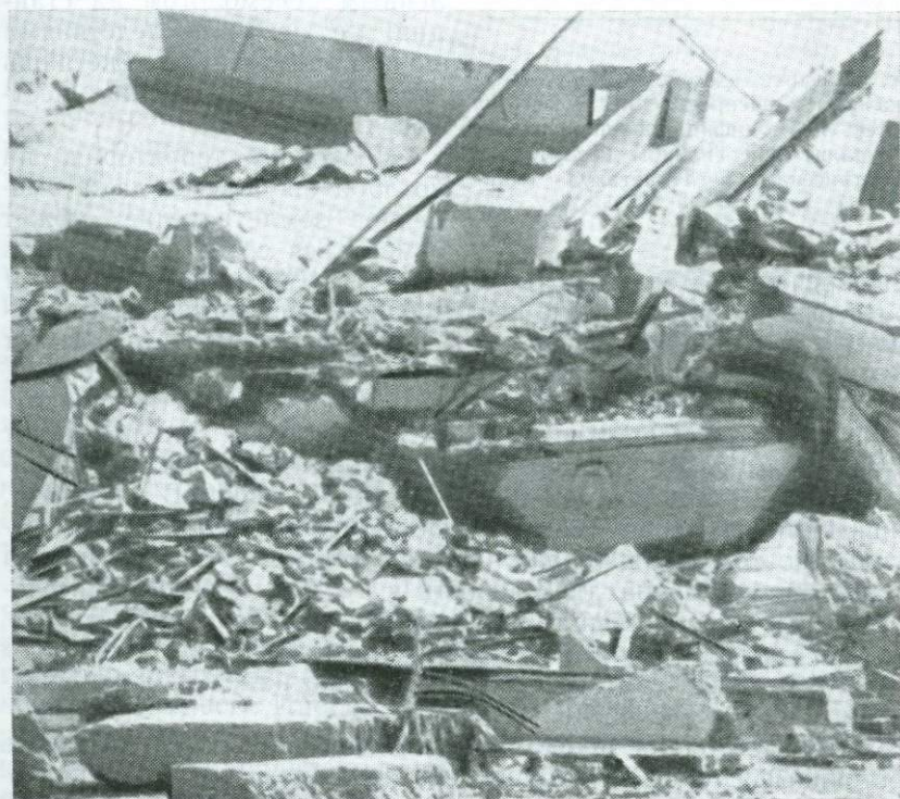
Рис. 2. Иллюстрация к шкале интенсивности. Полное разрушение здания лечебницы во время землетрясения 1931 г. отвечает интенсивности по меньшей мере ММ X
