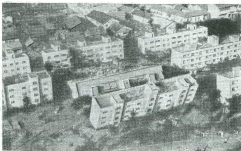
Рис. 130. Жилые дома в Ниигате после землетрясения. Обратите внимание на песчаные кратеры на переднем плане снимка
