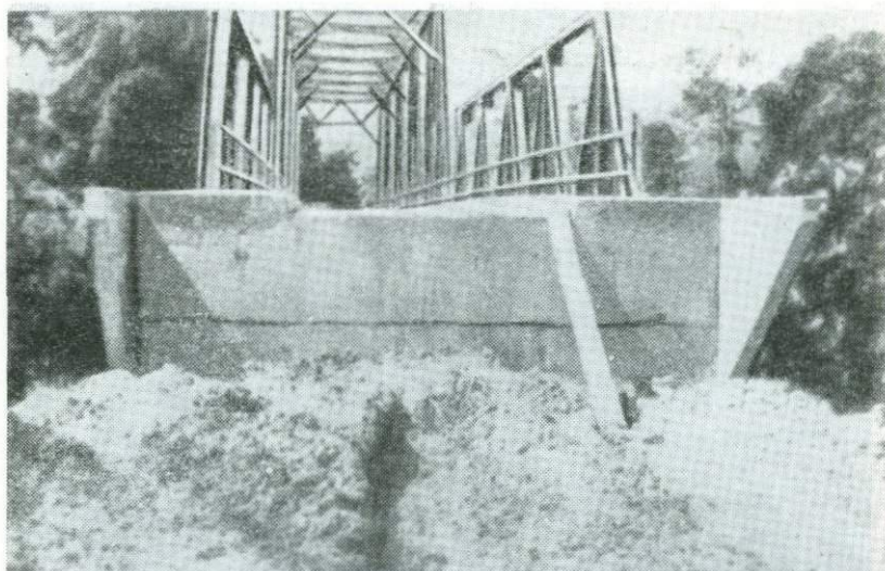
Рис. 128. Расчет этого моста в Новой Гвинее, очевидно, был ограничен его устоями. В результате оседания грунта, слагающего насыпь, поперек дороги образовалась стена
