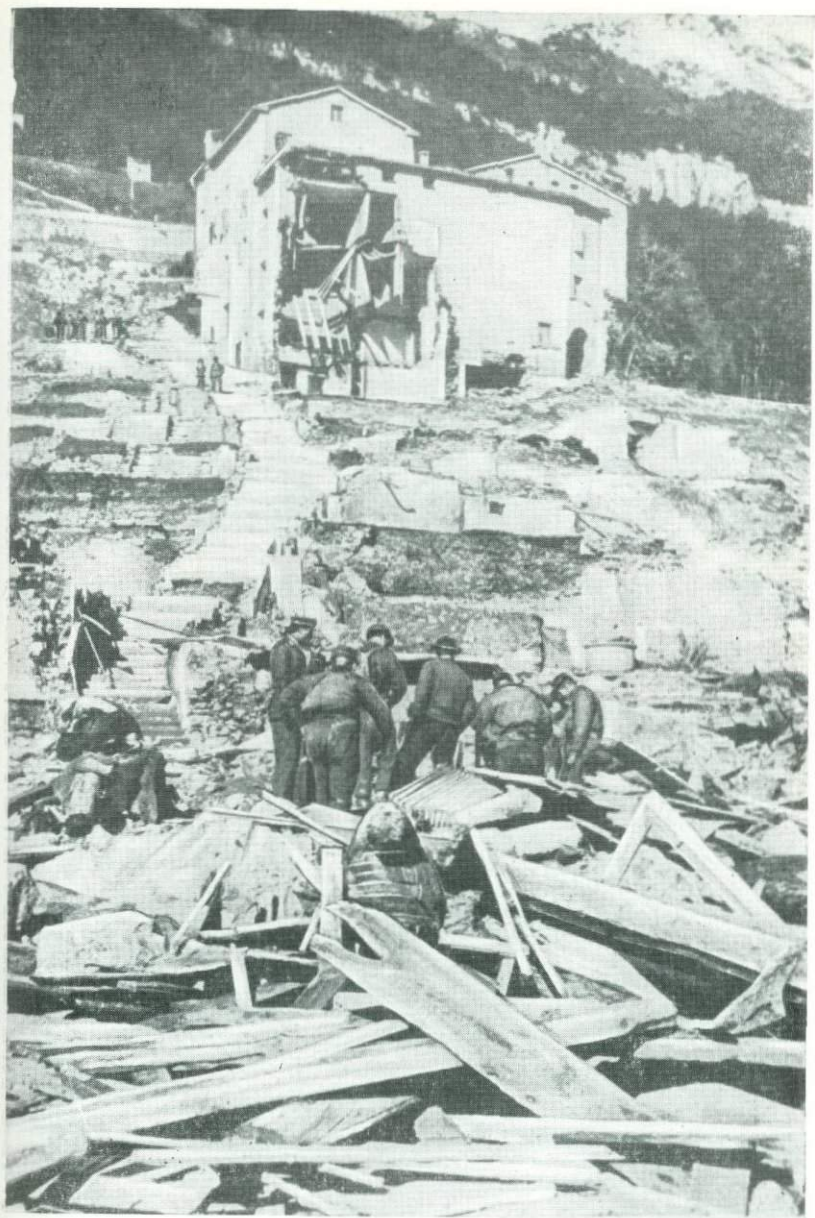
Спасательные работы в городке Лангароне, пострадавшем при обрушении плотины на реке Вайонт.
