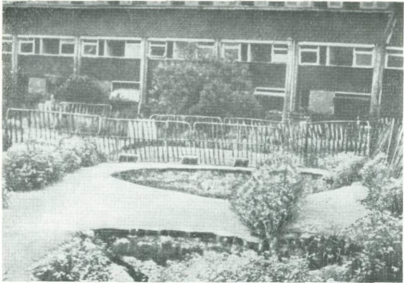
Провалы на улице Жаклин-Клоуз (Бери-Сент-Эдмендс), образовавшиеся в результате обрушения подстилающих меловых пород в старые горные выработки, которые находятся под этим районом.
