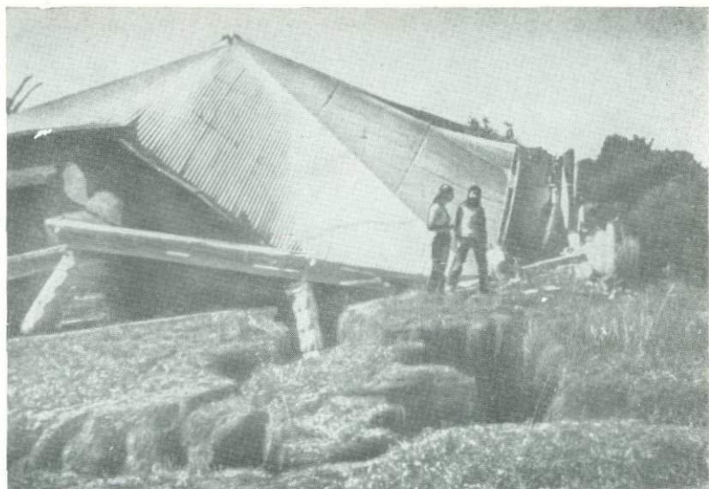
Трещины в земле и разрушенный дом — результаты проседания (Банка, Южная Африка, 1972 г.).
