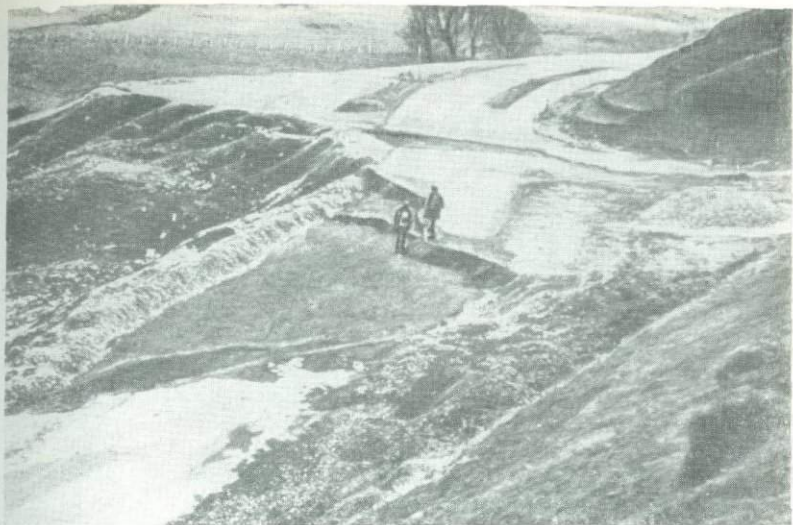
В 1977 г. при оползне на дороге, идущей по склону горы Мам-Тор, образовался почти метровый уступ.
