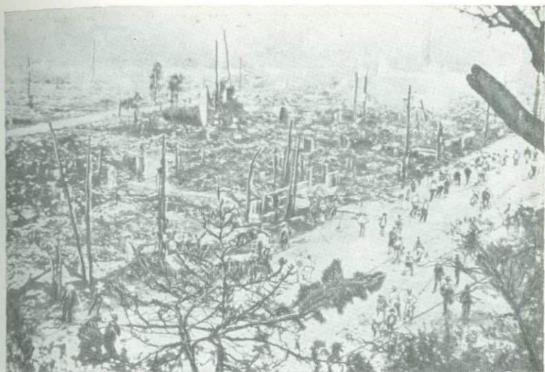
Станция Уэно в Токио после землетрясения 1923 г. Пожар завершил разрушение домов.
