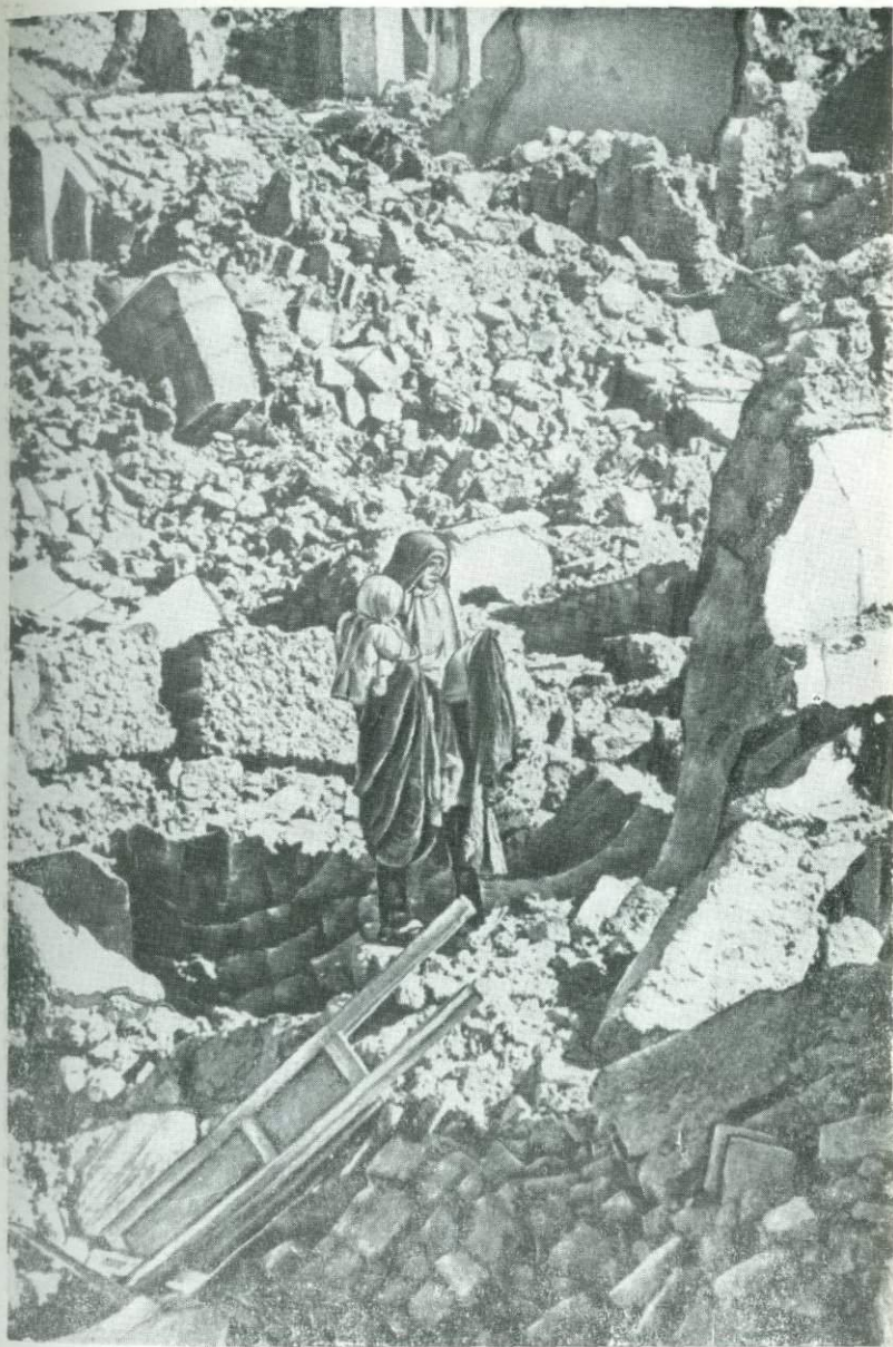
Среди обломков Иранского землетрясения 1965 г.; полностью разрушено множество глинобитных домов.
