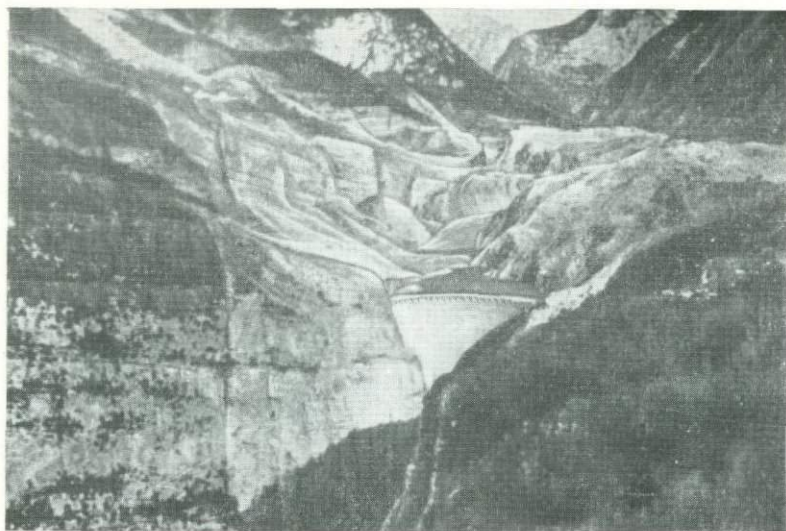
Плотина на реке Вайонт оказалась совершенно бесполезной, водохранилище заполнила оползневая масса, спустившаяся с горы Маунт-Ток (справа от участка на фотоснимке).
