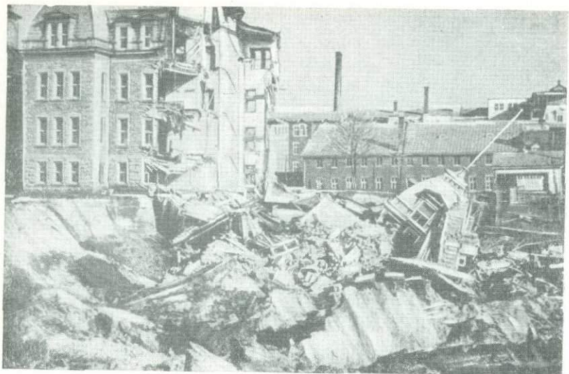
Разрушенные здания и груды обломков — последствия оползня, происшедшего в 1955 г. в канадском городе Николе.
