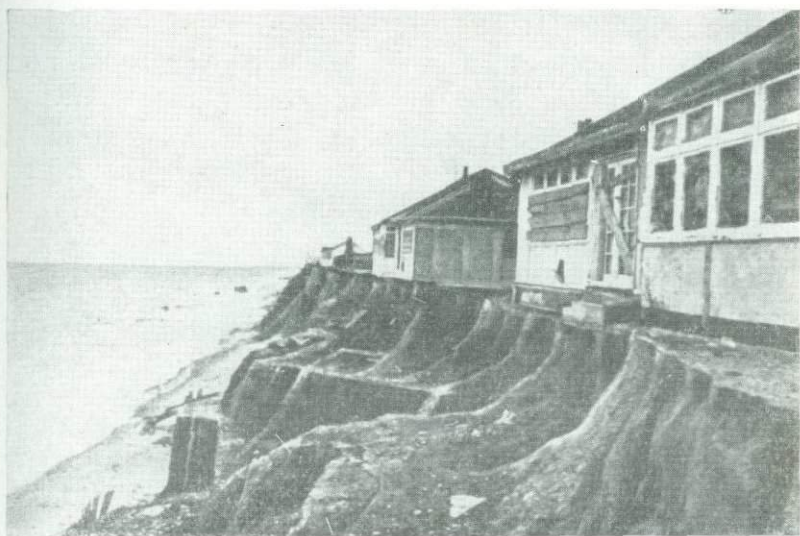
Коттеджи на вершине утеса в Скипси (Хамберсайд) расположены на опасном месте: неустойчивые утесы, разрушаемые водами Северного моря, уже неоднократно обрушились.
