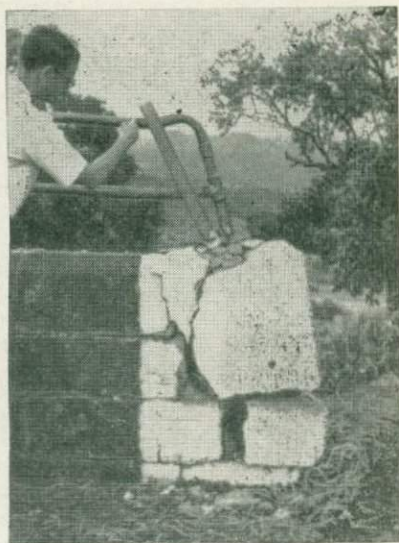
Р и с. 26. Повреждения кульвертов на дорогах.
