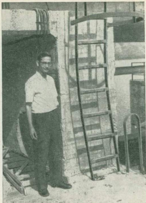
Рис. 33. Прогиб металлической лестницы в пультовой, расположенной на секции 24.
