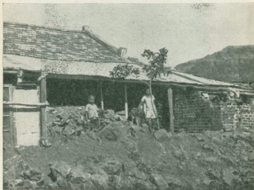
Рис. 216. Дома 1-й категории с менее разрушенными кирпичными стенами.
