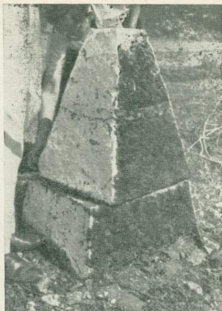
Рис. 11. Смещение столба с вращением в дер. Донечивади (эта и все приведенные далее фотографии сделаны Гуптой).
