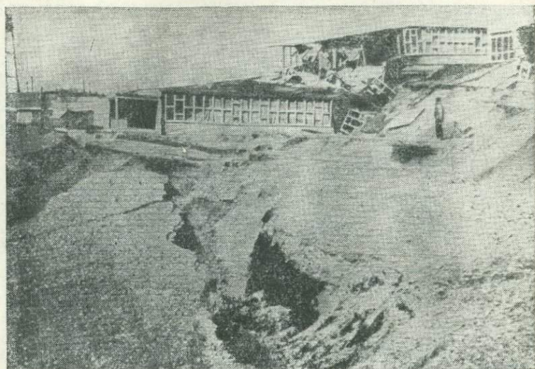
Рис. 13. Здание начальной школы, разрушенное катастрофическим землетрясением 1964 г. на Аляске
