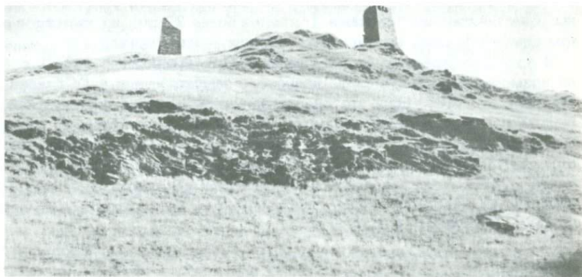
Рис. 4. Общий вид остатков крепости царицы Тамары в Верхней Сванетии. У одной из башен виден косой скол—характерный признак разрушения при землетрясении. Фото Р. Семенова
