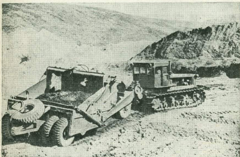
Рис. 9. Транспортировка грунта скрепером
