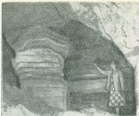
РИС. 48. Деформация столба-целика в одесских катакомбах
