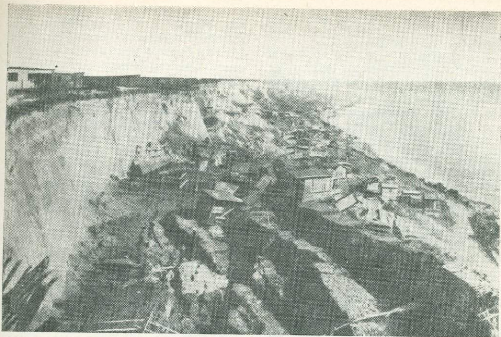
РИС. 13. Антропогенный оползень, Одесское побережье
