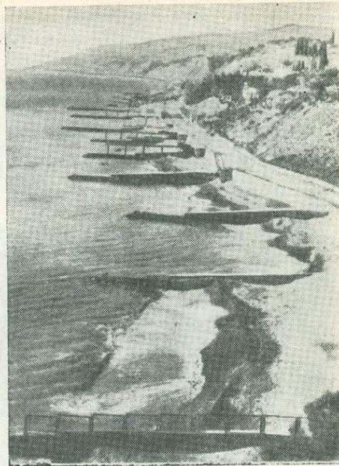
РИС. 28. Берегозащитные сооружения вблизи Ялты
