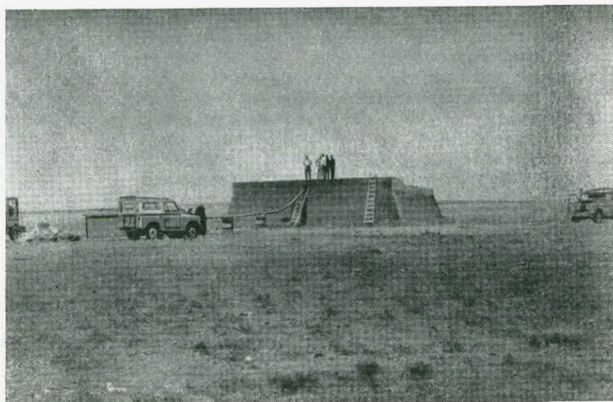
Рис. 13. Головное сооружение (накопительный бассейн) у скв. 41 на плато Ассасна
