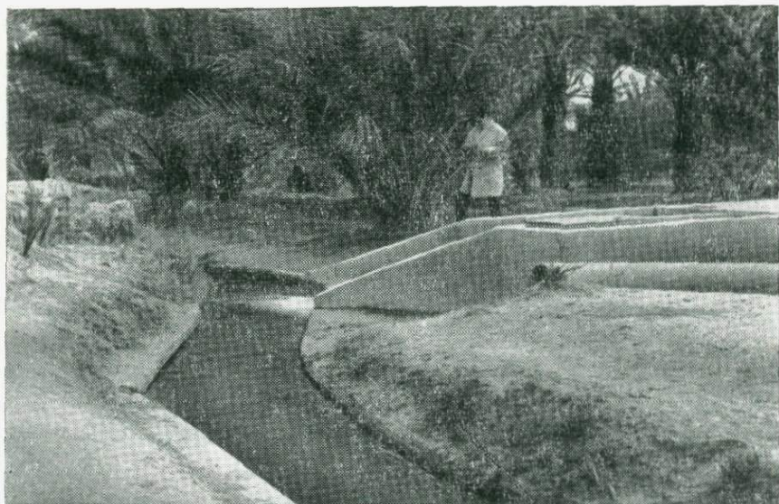
Рис. 33. Водозаборное сооружение и оросительный канал у самоизливающей скв. 2 в оазисе Бентус
