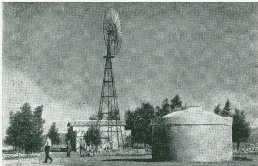
Рис. 14. Водоподъемник («ветряк») над трубчатым колодезем близ Шеллалы
