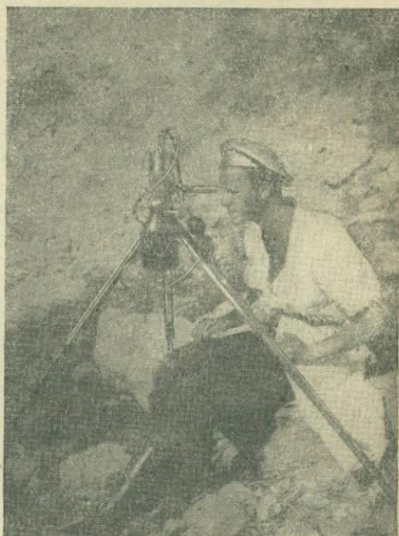
Фиг. 29. Работа с полевым \alpha -электроскопом системы Шмидта.
