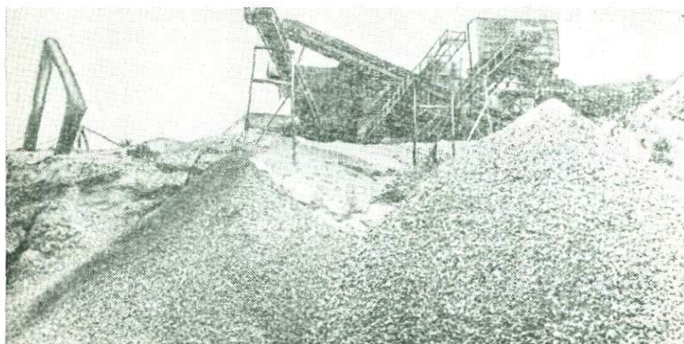
Рис. 8. Переработка пород вскрыши Сорского рудника на щебень
