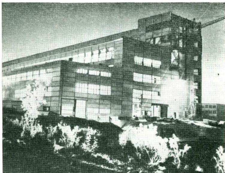
Рис. 1. Главный корпус обогатительной фабрики Лебединского горнообогатительного комбината (КМА) Фото О. Сизова, А. Кузырина
