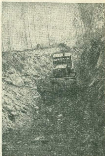
Рис. 2. Проходка разведочной канавы бульдозером
