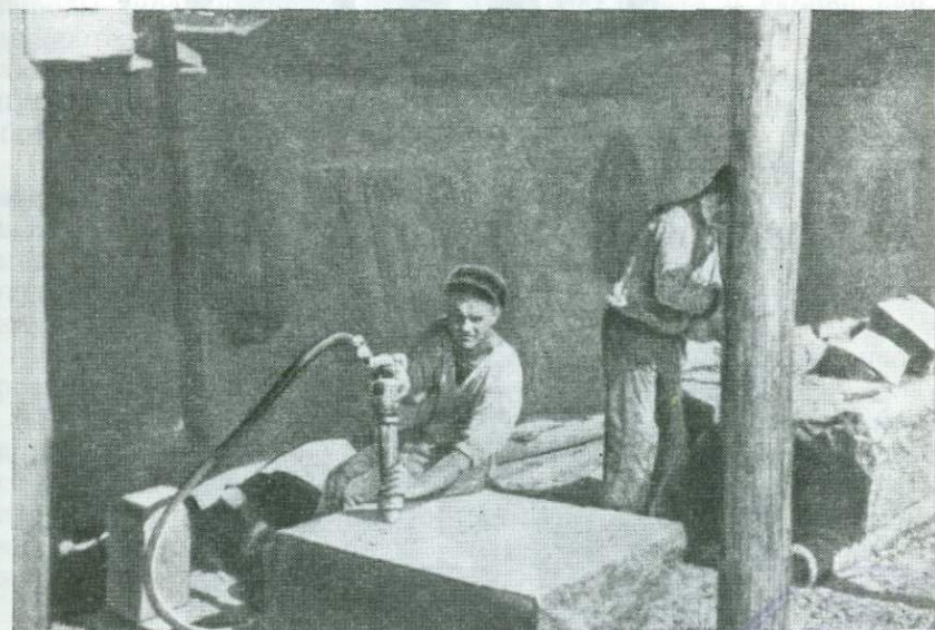
Фиг. 8. Механическая обработка поверхности гранитного блока бучардой Армянская Республика Министерство культуры Архивная печать 1990
