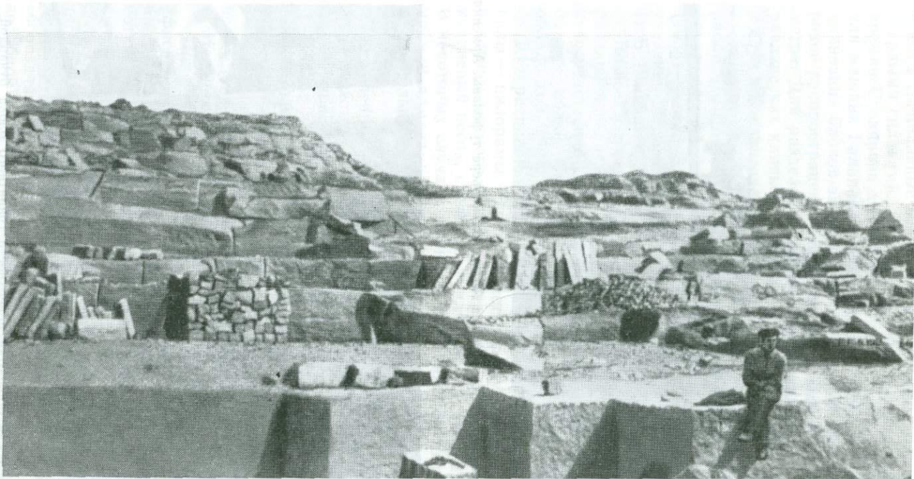
Фиг. 9. Общий вид гранитного карьера Старая Карань, близ Жданова Хорошо видна пластовая отдельность гранита
