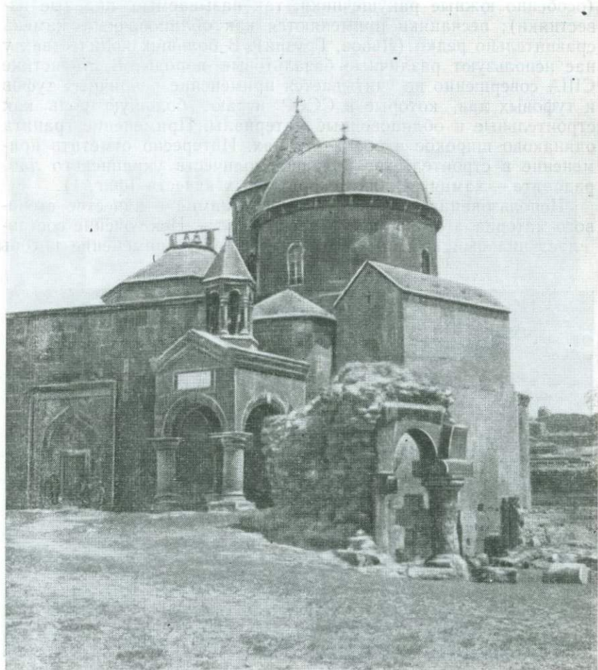
Фиг. 2. Памятники древней архитектуры в селении Кипчяг (Аричж), Армения. Храм сооружен из арктической туфовой лавы. Передняя полуразрушенная часовня сооружена в V в. Главный храм построен в XIII в.
