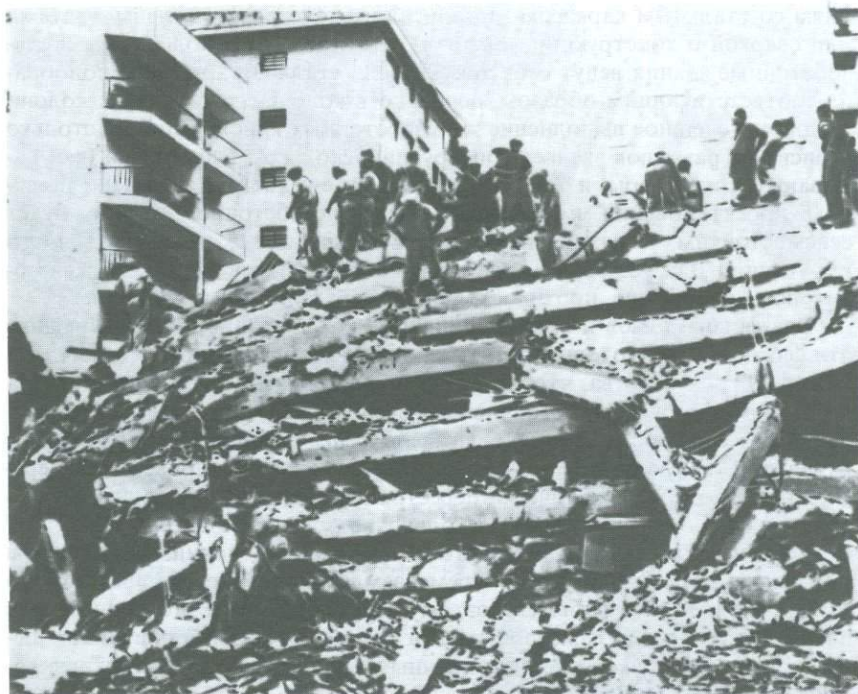
12-этажное жилое здание в Каракасе (Венесуэла) рухнуло при землетрясении 1967 г. (магнитуда 6,5). [С разрешения Калифорнийского управления шахт и геологии.]
