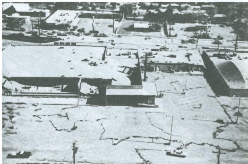
Торговый центр в Сан-Фернандо был так сильно поврежден землетрясением 1971 г., что его пришлось снести. Фото Р.Э. Уоллеса. [С разрешения Геологической службы США.]
