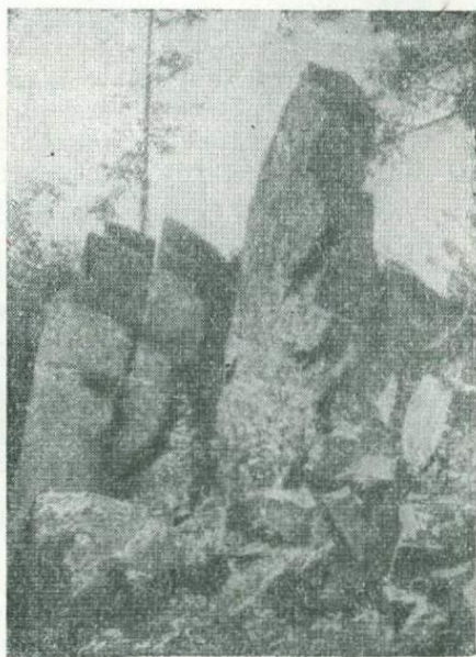
Рис. 30. Трещины отдельности (в граните).
