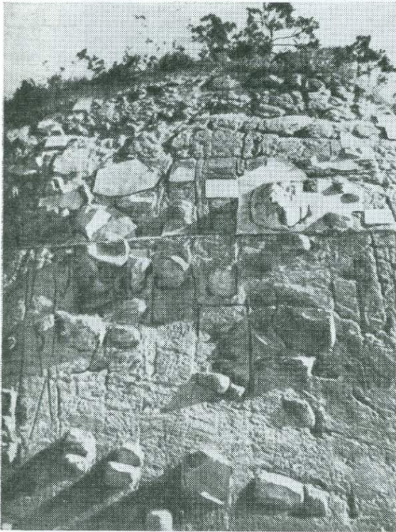
Рис. 120. Ядра свежего гранита в сапролите, сохранившем первичную отдельность, Гонконг
