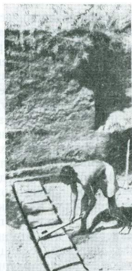
Рис. 99. Вырезка строительных латеритных блоков в Потхукунду, штат Керала (Индия)
