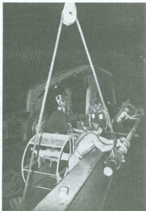
Рис. 9.2. Получение плейстоценовых осадков с помощью грунтовой трубки. Работы ведутся с трубкой большого диаметра, в концевой части виден белый осадок. Обратите внимание, что во время операции по подъему трубки она привязана. На палубе видно другое оборудование: рама камеры подводного фотографирования (с защитной сеткой), коса для сейсмопрофилирования (намотана на катушку), коробчатый дночерпатель (на заднем плане). Скрипсовский океанографический институт, экспедиция на «Эвридик», 1975.
