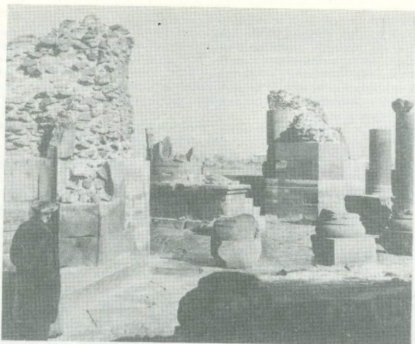
Р и с. 8.1. Руины храма Звартноц (Армения), разрушенного землетрясением 972 (?) года. Современное состояние (фото Г.П. Горшкова)
