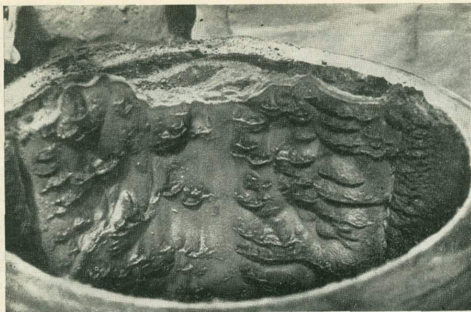
Рис. 59. Кора сфалерита в трубопроводе
