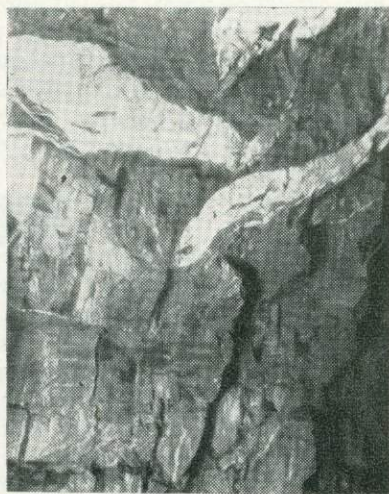
Рис. 56. Расщепление рудной жилы при встрече вертикальной зоны трещиноватости при отсутствии пострудной подвижки. Восточная жила, горизонт 60 м, шахта 6, Восточный участок Бестюбе
