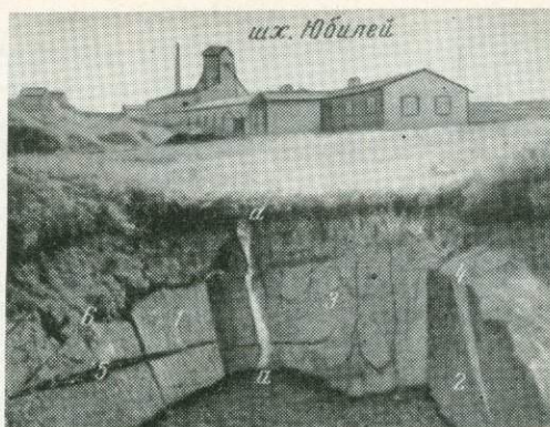
Рис. 6. Система мобильных трещин, расчленяющих Степяжский рудомещающий диоритовый массив на блоки.
