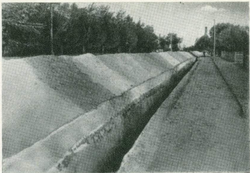
Рис. 102. Водопроводная канава, вскрывшая поверхностную зону выветривания Кочкарского рудовмещающего плагиигранитового массива в меридиональном направлении, вкост простираения рудных жил на интервале между шахтами Красная и Октябрь. Полосы отражают интенсивность окраски гидроокислами железа (белая, желтая, бурая, вишнево-бурая, розовая, фиолетово-бурая), варьирующего состава плагиигранита и многочисленных жильных пород
