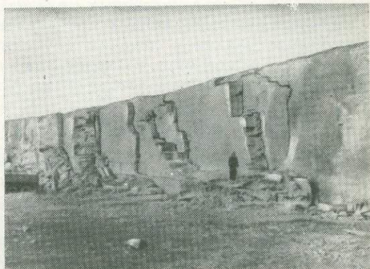
Рис. 184. Зона вертикальных разломов меридионального простирания в гранитном массиве, несущих следы сдвиговых перемещений (борозды, глинка). Челябинский каменный карьер
