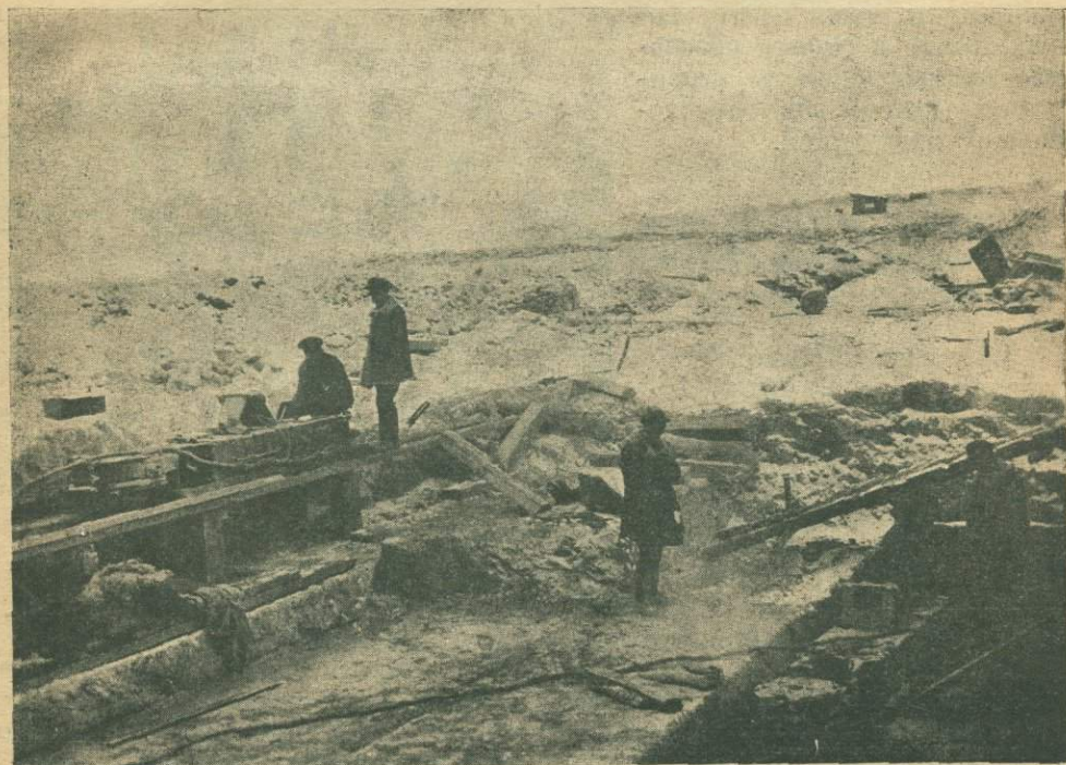
Рис. 23. Площадка карьера разработок врубовой машины.
