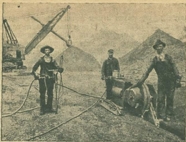
Рис. 20. Вертикальный пропил врубной машины.
