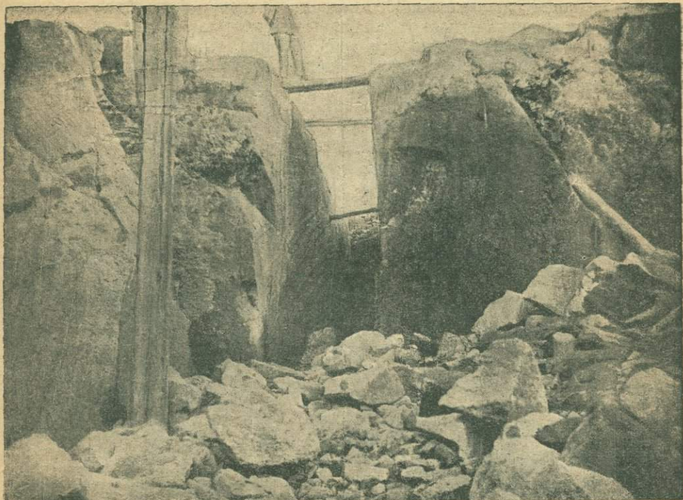
Рис. 17. Траншея, пропиленная стальным канатом.
