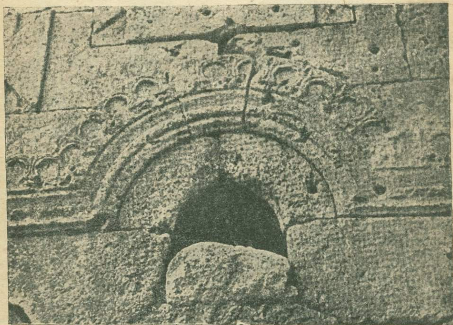
Рис. 61. Махмуджугская церковь. Северное окно. Конструкция арки и кладки.
