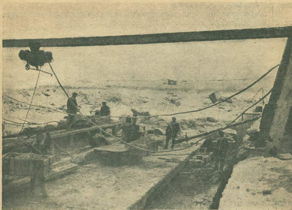
Рис. 22. Площадка карьера разработок врубовой машины.
