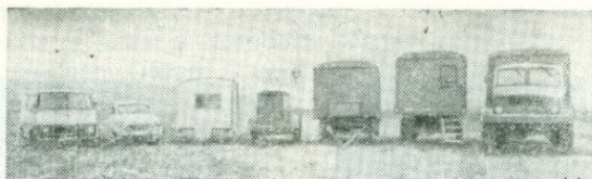
Рис. 98. Общий вид комплекса передвижных агрегатов отделения гидротехники Исследовательского института инженерной геологии, предназначенных для гидрогеологического исследования газонасыщенных вод (состояние на 1973 г.). Справа налево: измерительная автомашинна, передвижная сепараторная станция, передвижная лаборатория, дизельная электростанция, передвижная канцелярия, дежурная автомашинна обслуживающего персонала, передвижная мастерская (фото И. Котоучек)
