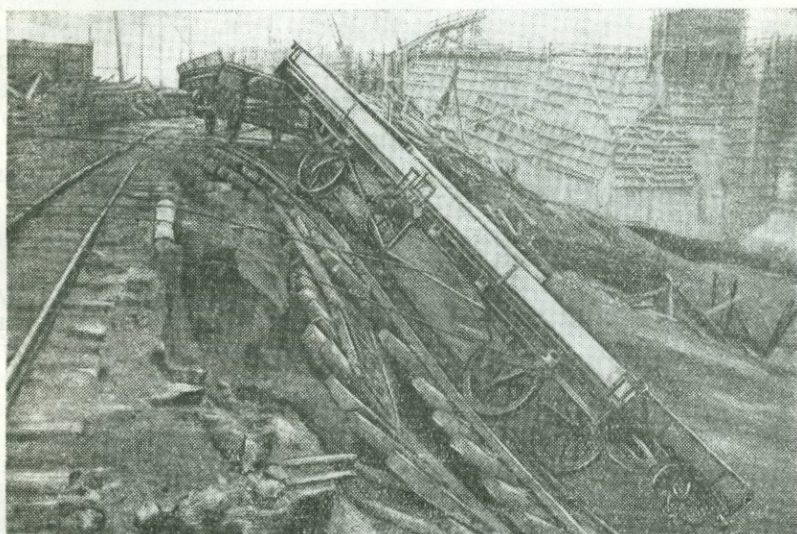
Рис. 162. Оползание песчаной подсыпки по глинистому откосу.
