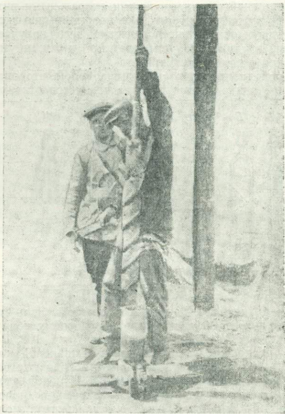
Рис. 163. Бурение змеевиком.
