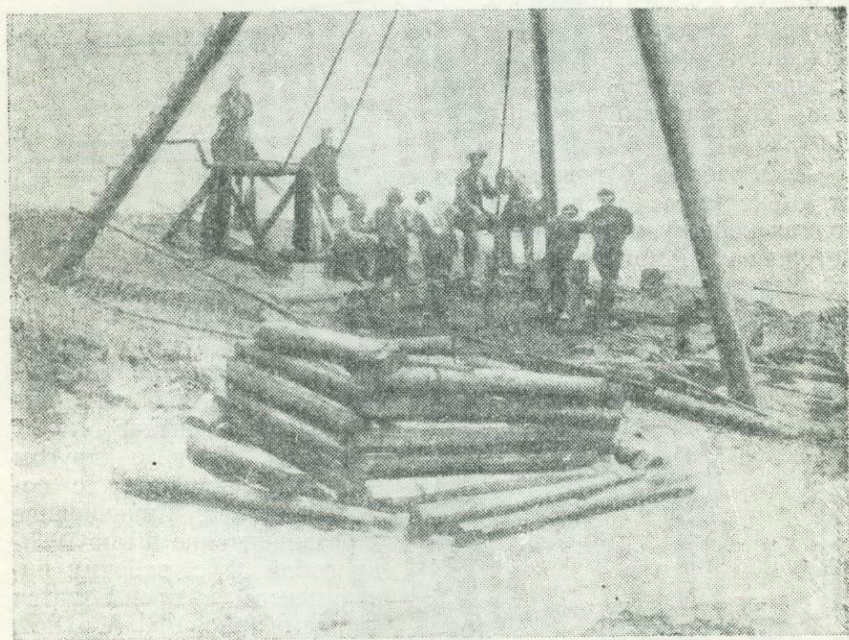
Рис. 166. Ручное вращательное бурение.
