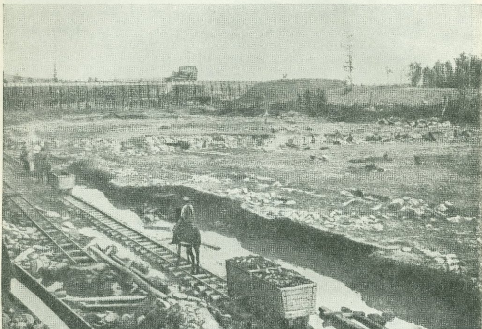
Фиг. 19. Разработка платиносодержащих «песков» на Нижне-Исовском прииске. Все вышележащие породы сняты экскаватором. По Дюпарку.
