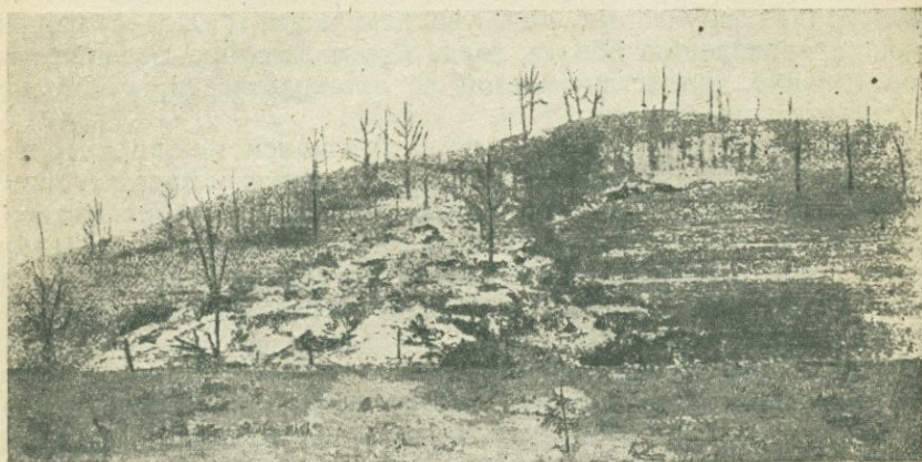
Рис. 27. Оползень глинисто-щебнистых склонов (фотогр. Бюро общ. дорог в Вашингтоне).
