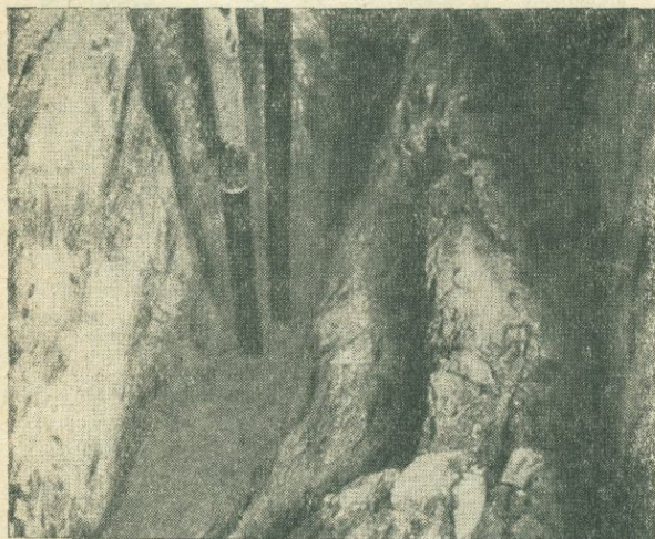
Рис. 197. Карлсбадская термальная трещина. Работы по вскрытию в заново каптируемом Шлосс-бруннене в 1911 г. Термальная вода образует в зияющей трещине парующую поверхность; в воду опущены две трубы (из «Balneologie u. Balneotherapie», 1922)
