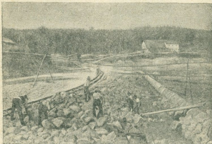
Рис. 128. Заполнение каптажа источника близ Ранны.
