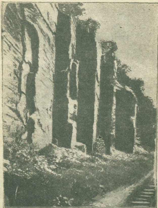
Рис. 8. Пересекающиеся ряды вертикальных трещин в горизонтальных осадочных пластах. По Киндлю (Kindle, U. S. Geol. Survey).
