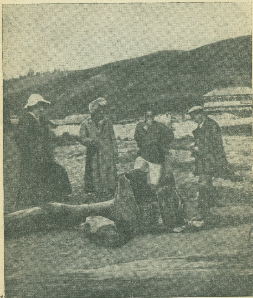
Рис. 1. Закрепление сероводородного источника стволом дерева в с. Цители-Сагдари (Грузия).
