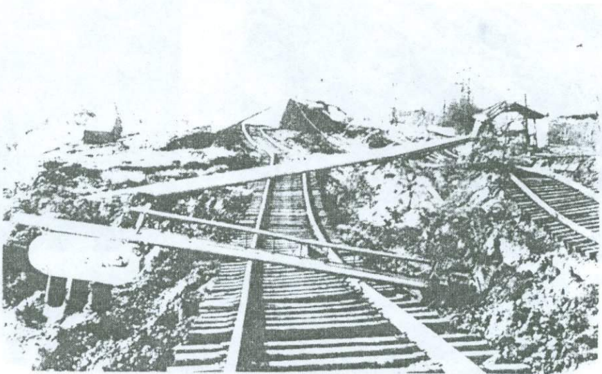
Սկ. 1.8 Երկաթգծերի ծռնվածքներ Սպիտակի երկրաշարժից՝ Նալբանդի շրջակայքում գետնի շրջիկացման պատճառով [151]:
