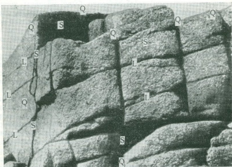
Рис. 135. Главные первичные трещины в обнажении сиенитов Кольского полуострова
