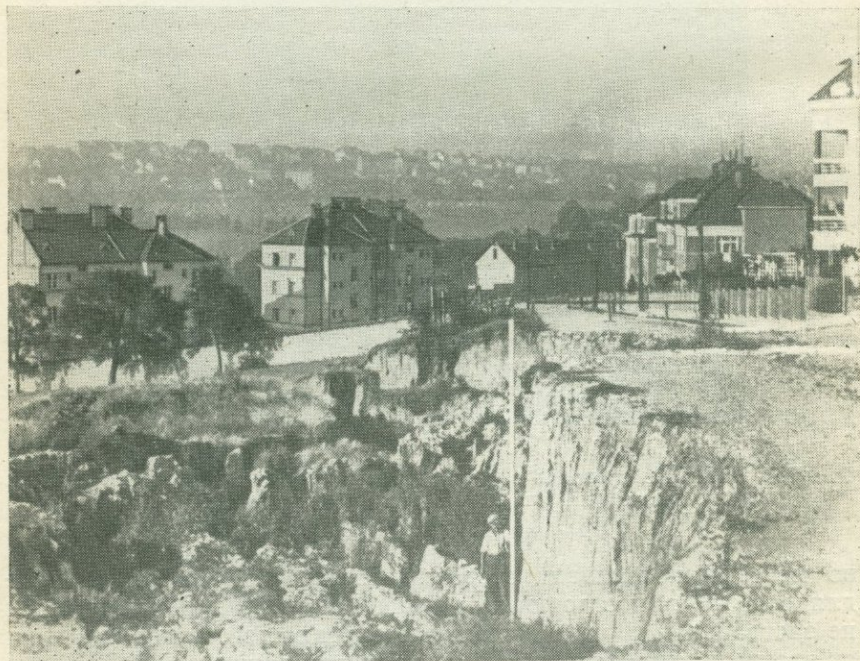
Рис. 9.10. Оползни на крутых бортах старого карьера кирпичных глин в пригороде Праги, грозящие устойчивости близрасположенных зданий (фото Зарубы).
