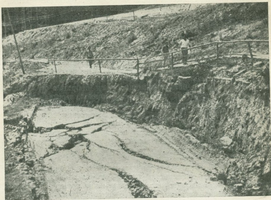
Рис. 4.1. Автострада, разрушенная оползнем, возникшем при вскрытии котлована для опоры плотины, восточная Словакия (фото Зарубы).
