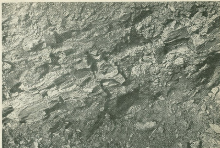
Рис. 6.11. Трещиноватые неогеновые глины в железнодорожной выемке близ Моста (фото Менцла).
