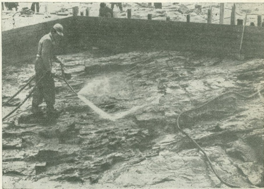
Рис. 8.18. Очистка поверхности пород основания плотины Орлик в Чехии струей воды под напором и сжатым воздухом (фото Зарубы).
