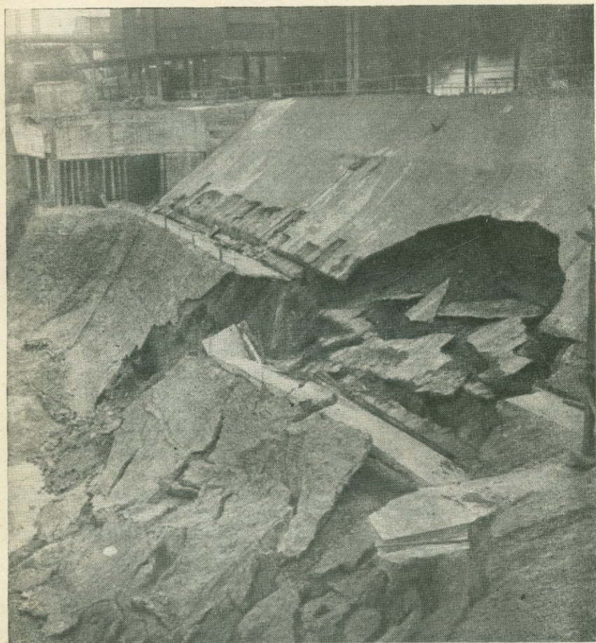
Рис. 5.21. Разрушение откоса котлована в неогеновых глинах (фото Менцла).
