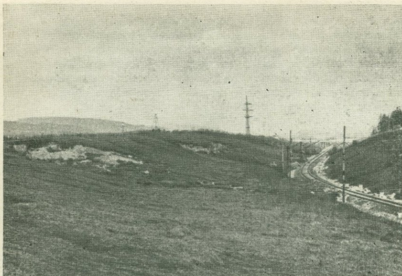
Рис. 6.8. Деформация пологого откоса дорожной выемки в неогеновых глинах вблизи Ческа-Тршебова (Восточно-Чешская область), вызванная подземными водами (фото Менцла).
