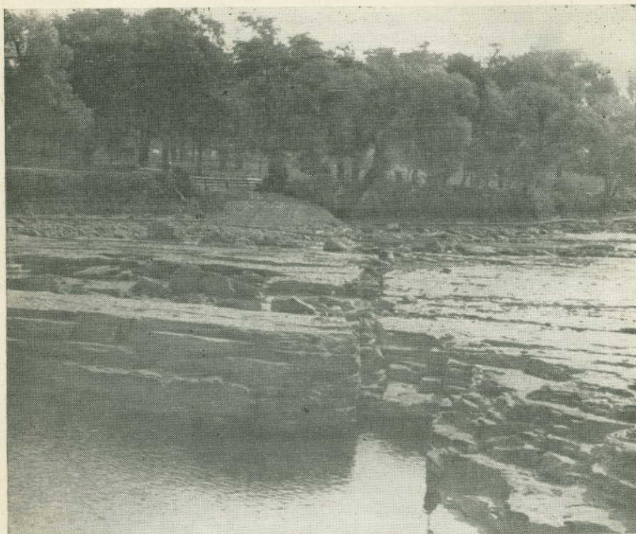
Рис. 2.32. Трещины отрыва в силурийских доломитах Локпорт около гребня американской части Ниагарского водопада.
