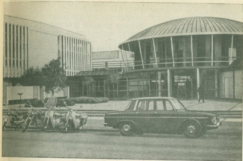
Рис. 2. Вход в здание Инженерной школы в университетском городке в Крайстчерче
