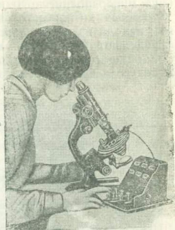
Рис. 46. Пуш-интегратор Глаголева (модель 1935 г.).
