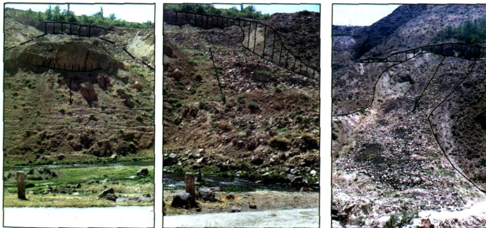
Рис. 43. Оползни на левом борту долины р.Раздан у санатория “Арзни” (фото В.Р.Бойнагряна)
