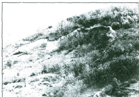
Рис. 58. Общий вид Арфикского оползня
