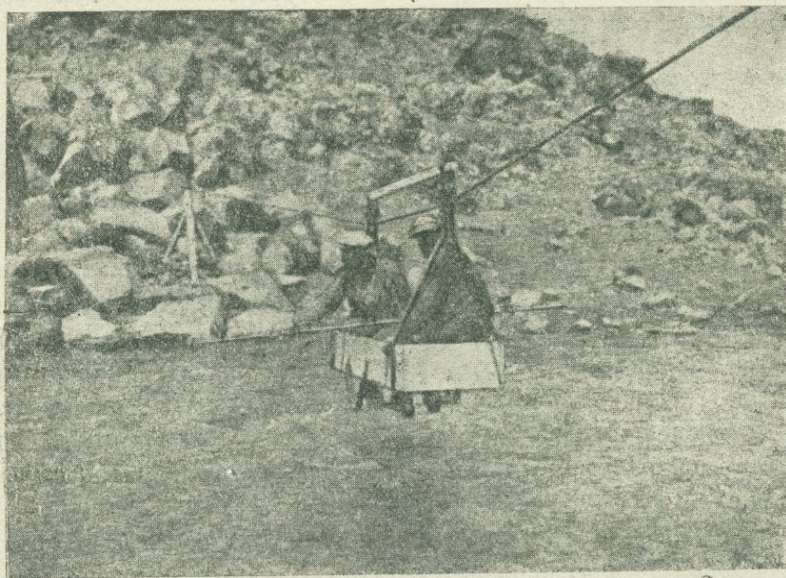
Рис 15. Гидрометрический створ на р. Адиаман-чай. Определение расхода с люльки.
