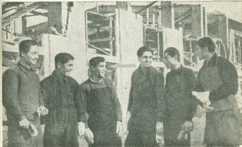
Бригада коммунистического труда на строительстве химического завода в Кировакане
