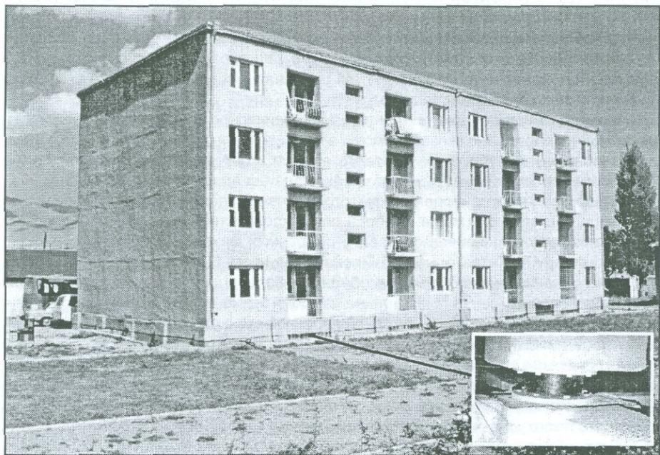
Рис. 3.4(9) 4-этажный дом в г. Спитак, построенный на сейсмоизоляторах.
