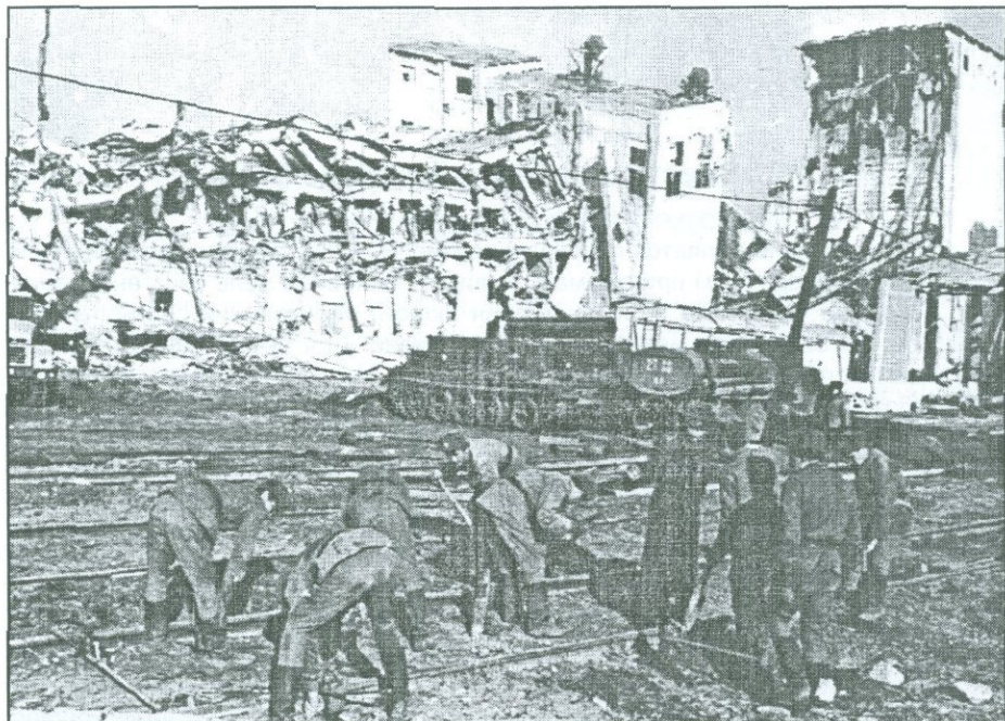
Рис. 5.1(1) Восстановление поврежденных железных дорог одна из приоритетных задач этапа восстановления. Оно начинается после спасательных работ, когда город еще не очищен от завалов (Спитак, 1988г.), (фото М. Шахбазяна и др. из книги «Землетрясение», 1989).
