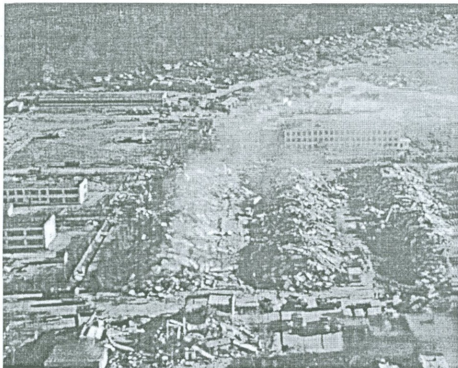
Рис. 4.6(1) Обрушение 5-этажных крупнопанельных домов в г. Нефтегорске (Сахалин, Россия), вследствие IX-балльного (по шкале MSK-64) землетрясения 1995г. (Землетрясение неизбежно..., 1997). Хорошо видна характерная форма завалов протяженных зданий.
