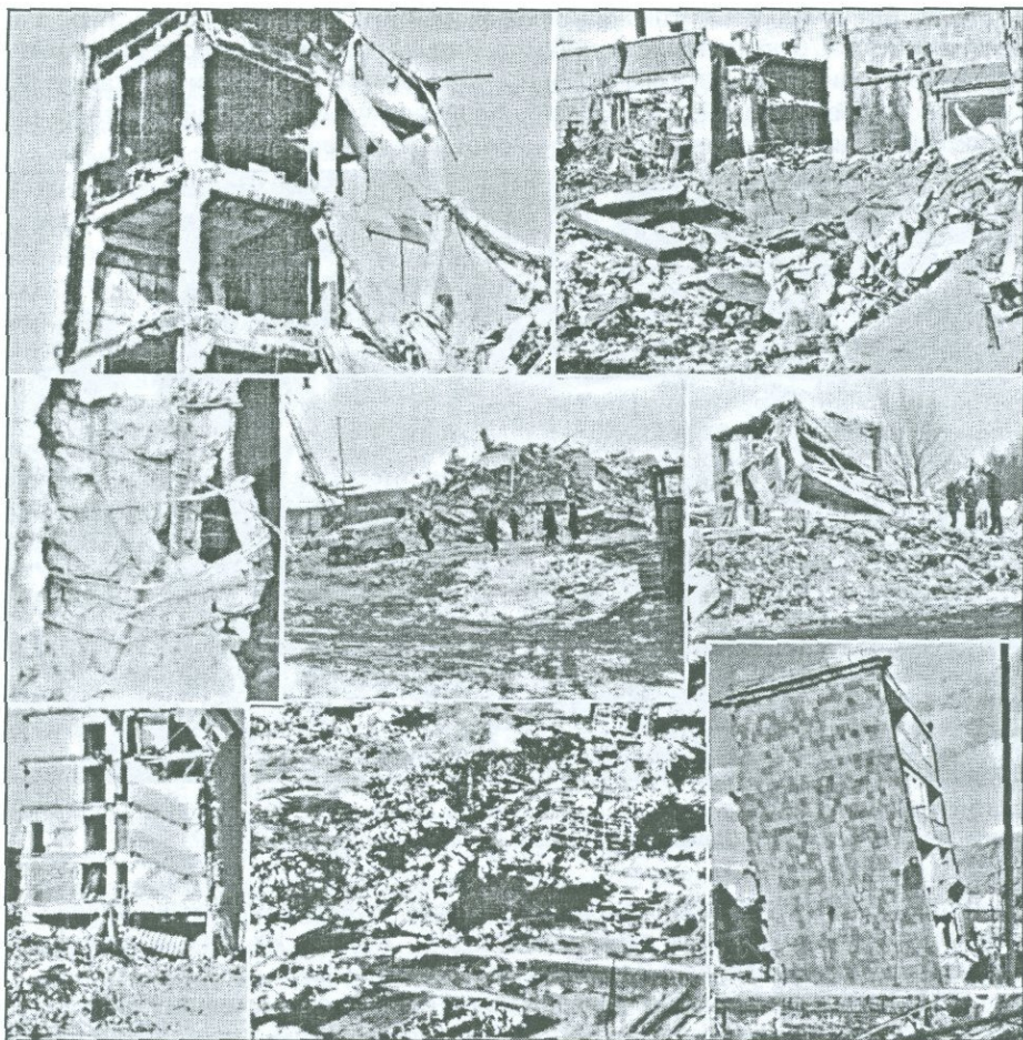
Рис. 1.6(22) Разрушения в 10-балльной зоне Спитакского землетрясения (фото М. Шахбазяна и др. из книги «Землетрясение», 1989г.).
