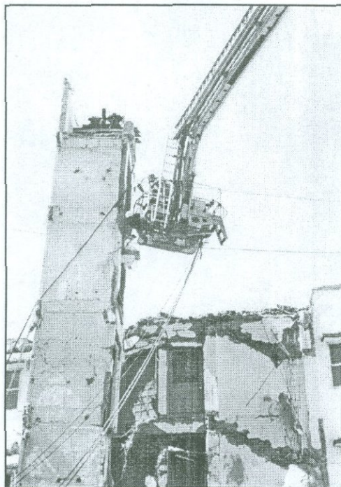
Рис. 3.9(7) Процесс демонтажа сильно пострадавшего сооружения специалистами СБР.
