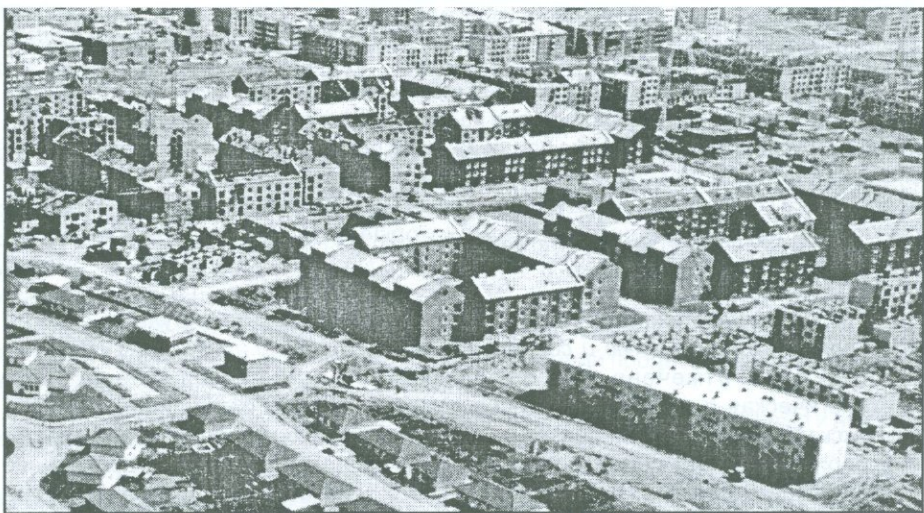
Рис. 5.3(1) Начало (а) строительства нового квартала «Ани» в г.Гюмри в 1990г. и завершение(б) в 2001г., (фото М. Шахбазяна и др. из книги «Землетрясение», 1989).
