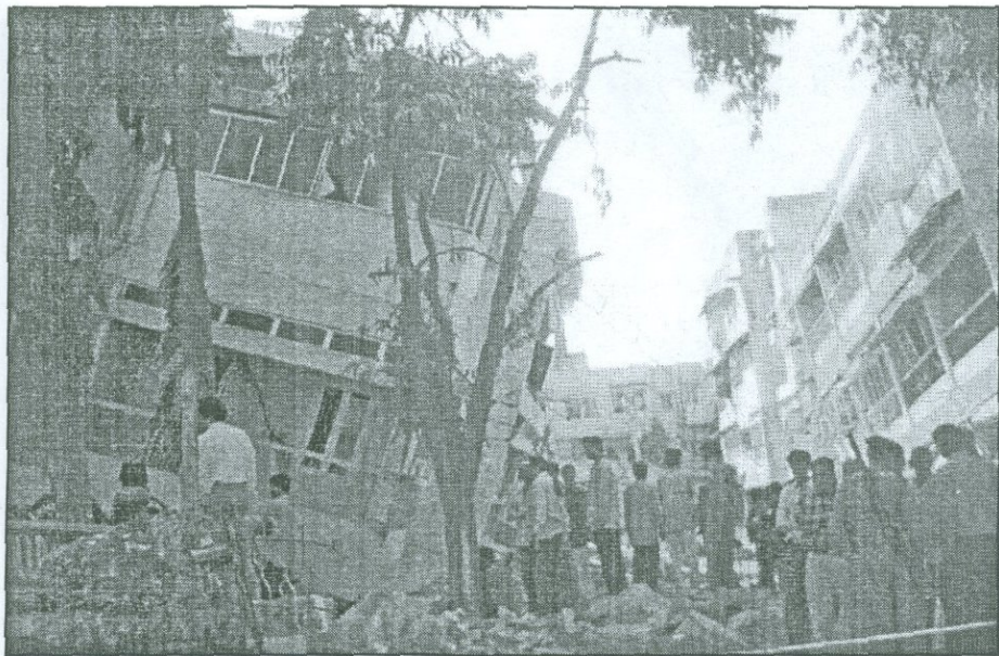
Рис. 3.9(6) Осмотр поврежденных зданий в Ахмедабаде инженерами-строителями СБР сопровождался большим интересом и доверием жителей города.
