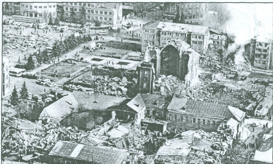
Рис.1.6(21) Панорама центра г. Ленинакан (ныне Гюмри) 7.12.88г. после Спитакского землетрясения (фото М. Шахбазяна и др. из книги «Землетрясение», 1989г.).
