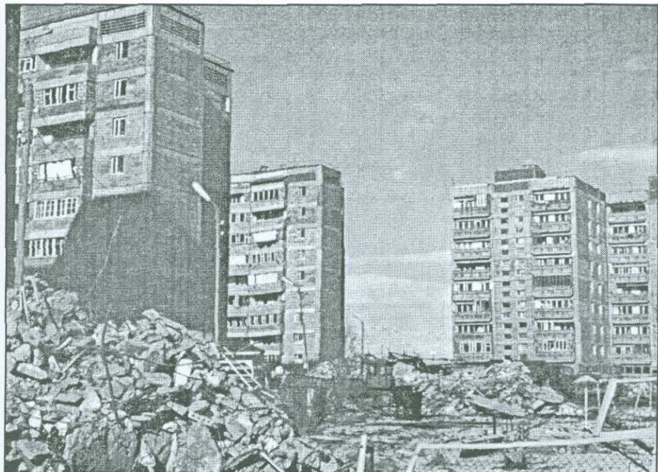
Рис. 3.4(5) Массовые разрушения 9-этажных каркаснопанельных зданий 111-ой серии при Спитакском землетрясении 1988г (Armenia Earthquake Reconnaissance Report, 1989).
